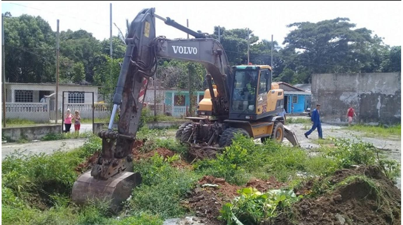
Mediante una retroexcavadora procedieron a despejar el terreno, hasta encontrar las conexiones de diferentes diámetros dañadas por los residuos acumulados.
